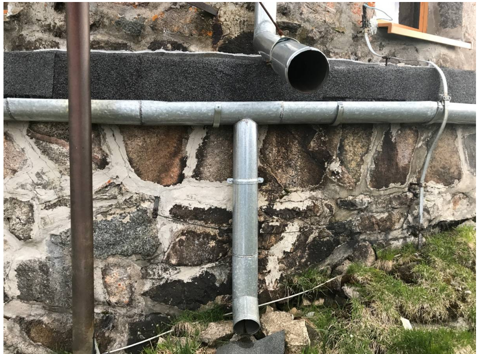
Fot. nr 7 Detal orynnowania – widoczne poważne zawilgocenie ścian
