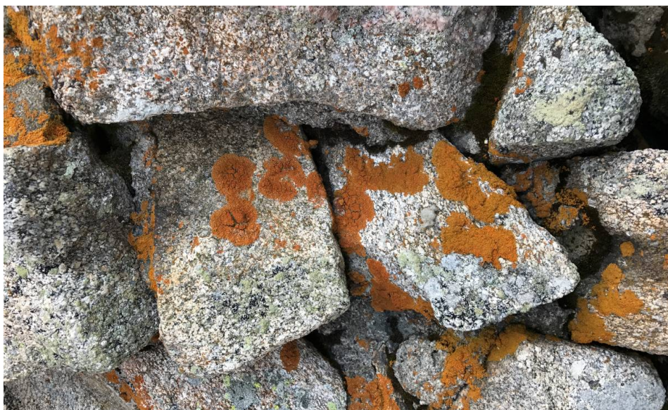
Fot. nr 3 Widok ściany od zewnątrz –obecność mikroorganizmów, poważne ubytki spoinowania
