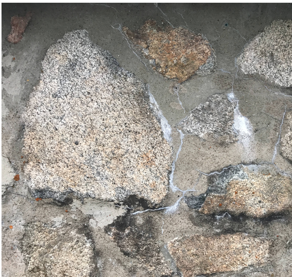
Fot. nr 2 Widok ściany od zewnątrz – zabrudzenia kamienia, obecność mikroorganizmów, wtórne spoinowanie zaprawami o różnym składzie, mikrospeknięcia w partiach spoin, widoczne wysolenia
