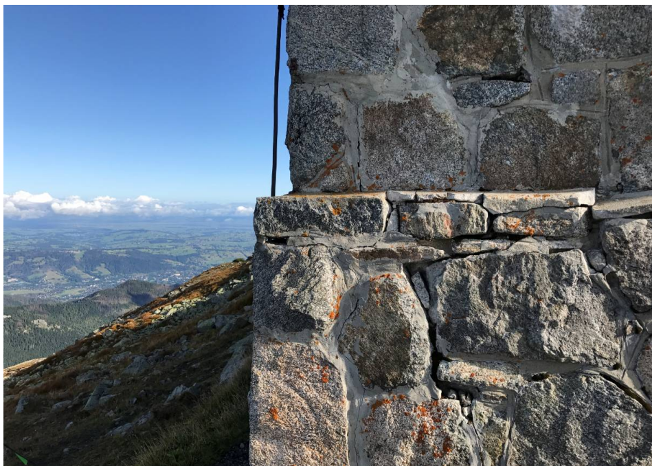
Fot. nr 4 Widok ściany od zewnątrz – obecność mikroorganizmów, poważne ubytki spoinowania, wtórne spoinowanie zaprawami o różnym składzie, mikrospeknięcia w partiach spoin, widoczne wysolenia
