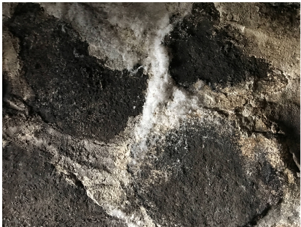
Fot. nr 1 Widok ściany od wewnątrz – zabrudzenia, obecność glonów, wtórne spoinowanie, widoczne wysolenia
